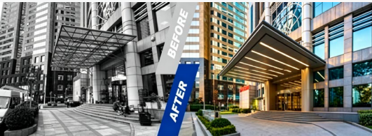
上海陆家嘴金穗大厦改造前后对比
