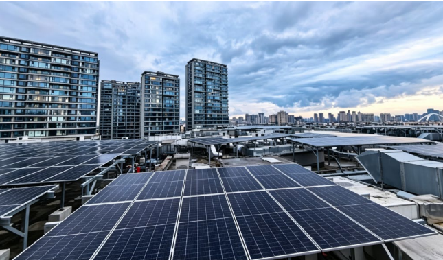
宁波海曙天街屋面光伏建设
