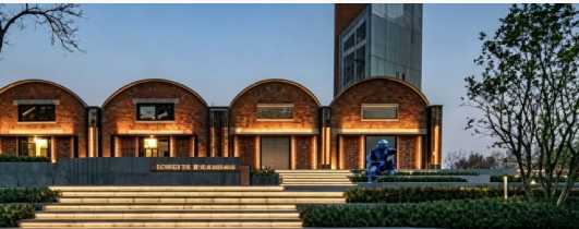
合肥车桥厂工业遗址改造前后对比
