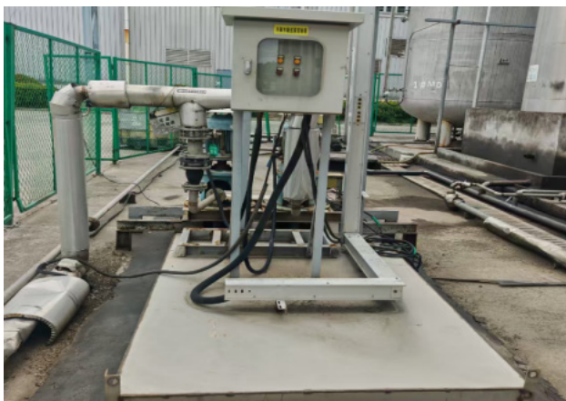
蒸气冷凝水回用系统
