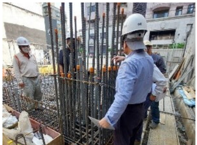
第三公正單位進行結構安全性能評估執行耐震工程品管查證照片
