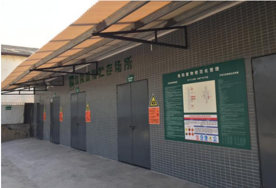
危险废物储存场所
