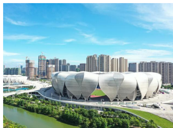
参与杭州亚运项目建设
