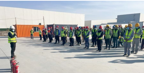
工程项目作业现场安全培训
