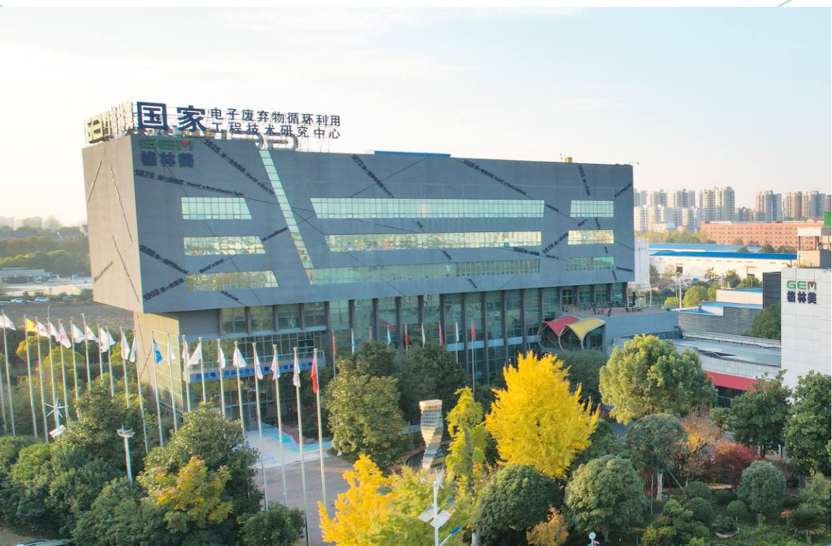
◀ 荆门园区循环经济大楼
