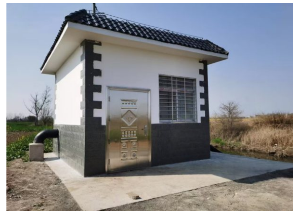
新修抗旱泵站
