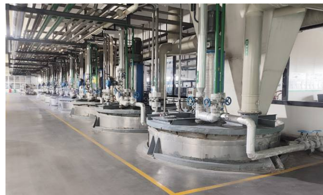
绿钨资源废弃钨资源回收利用改造项目
