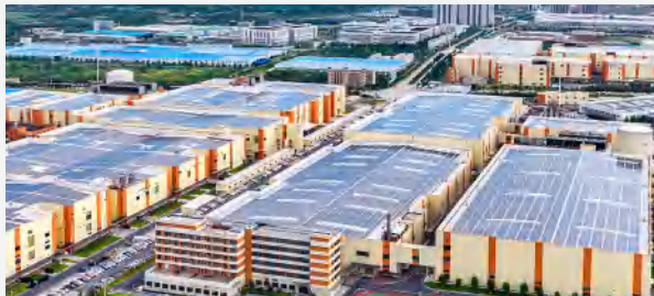
荆门基地屋顶光伏
