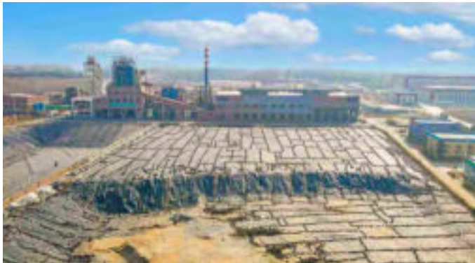
一般固废填埋场
