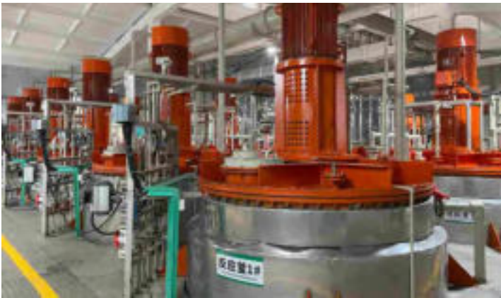
泰兴园区新建四氧化三钴产线
