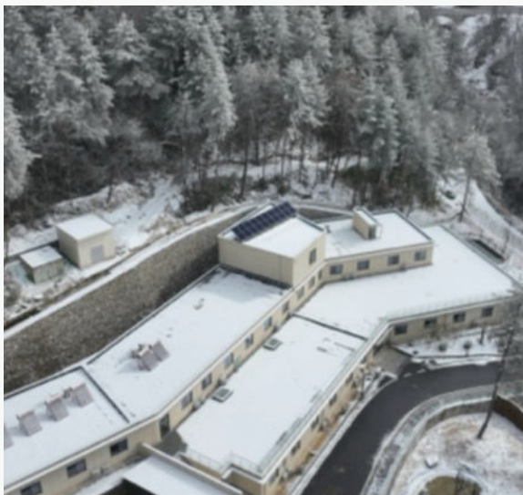
秦岭大熊猫佛坪救护繁育基地分布式光伏电站(2023年建成)
