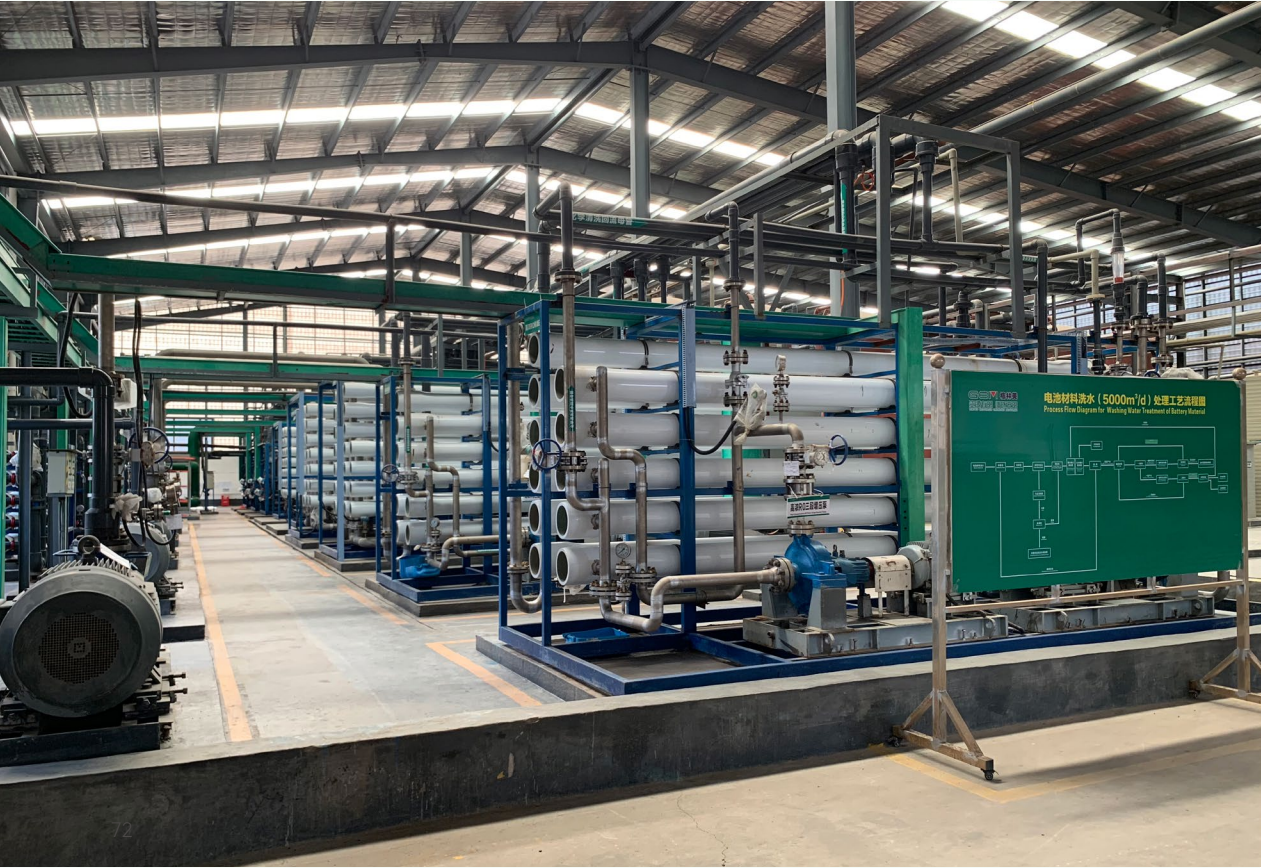
▲ 荆门园区反渗透膜系统
