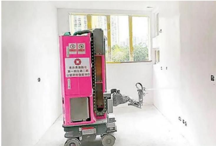
室内喷涂机器人进行全屋自动喷漆
