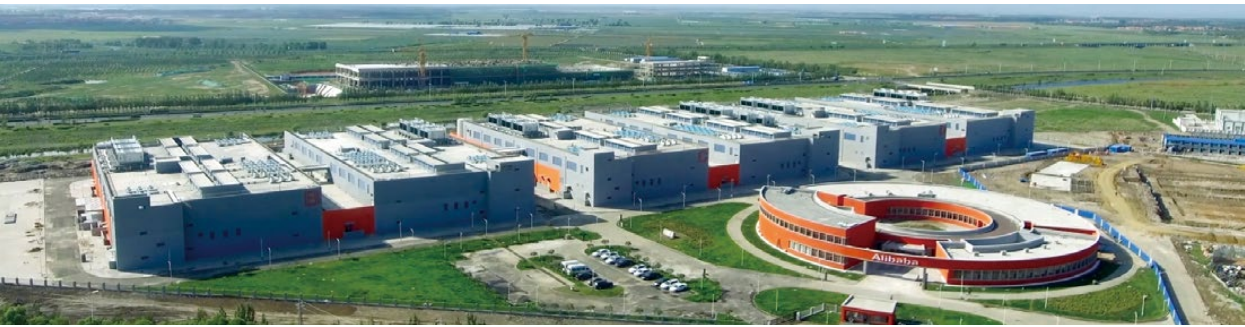
阿里巴巴张北数据中心全景图
