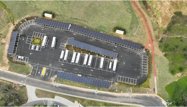
博鳌零碳示范区内采用“隆基隆行”光储充一体化产品建设的光伏车棚
