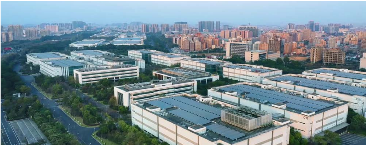
华为东莞南方工厂屋顶光伏电站
