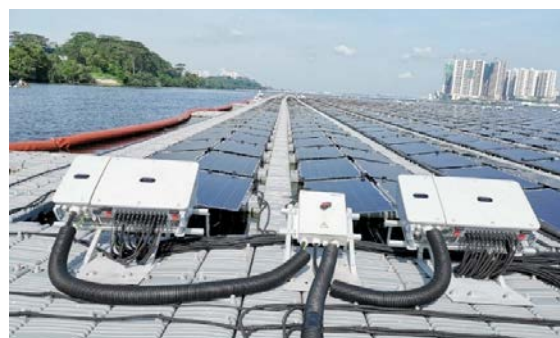
Sunseap 集团的 5 兆瓦海上漂浮电站 为土地稀缺、人口稠密，但水域面积广阔的国家 发展漂浮式光伏电站树立了典范
