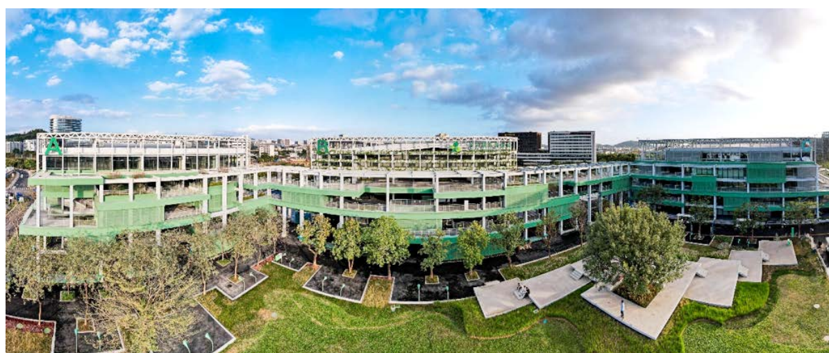
华为数字能源助力深圳国际低碳城打造了国内先进的近零碳排放场馆
