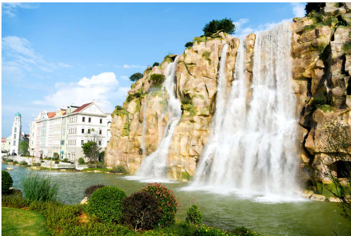
华为云贵安绿色数据中心，利用直通风、瀑布和湖水实现自然冷却，PUE 1.12，处于世界领先水平
