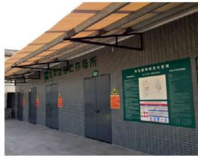
危险废物储存场所
