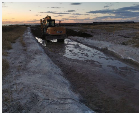
电站排洪治理工程
