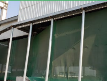
锂渣堆场周围加装防尘网
