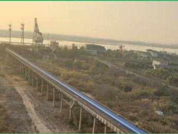
锂辉石进料输送皮带机安装防尘罩
