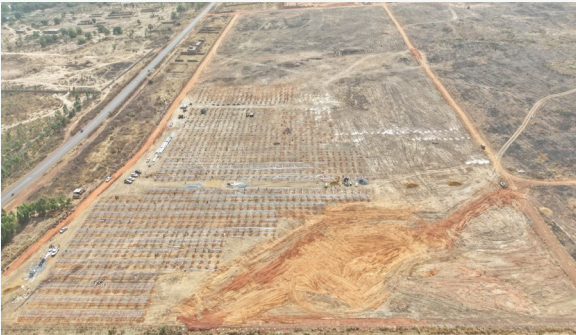
马里光储一体电站施工现场
